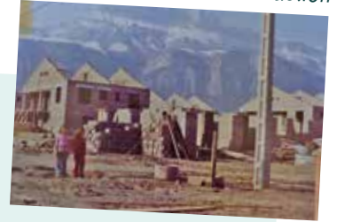
Les Castors en construction
