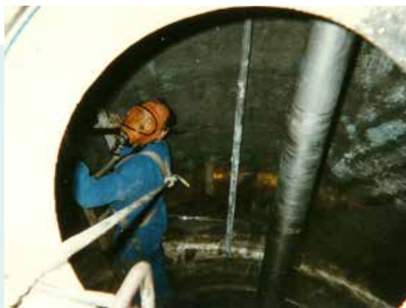
Nettoyage de reacteur fabrication de PVC en 1998
