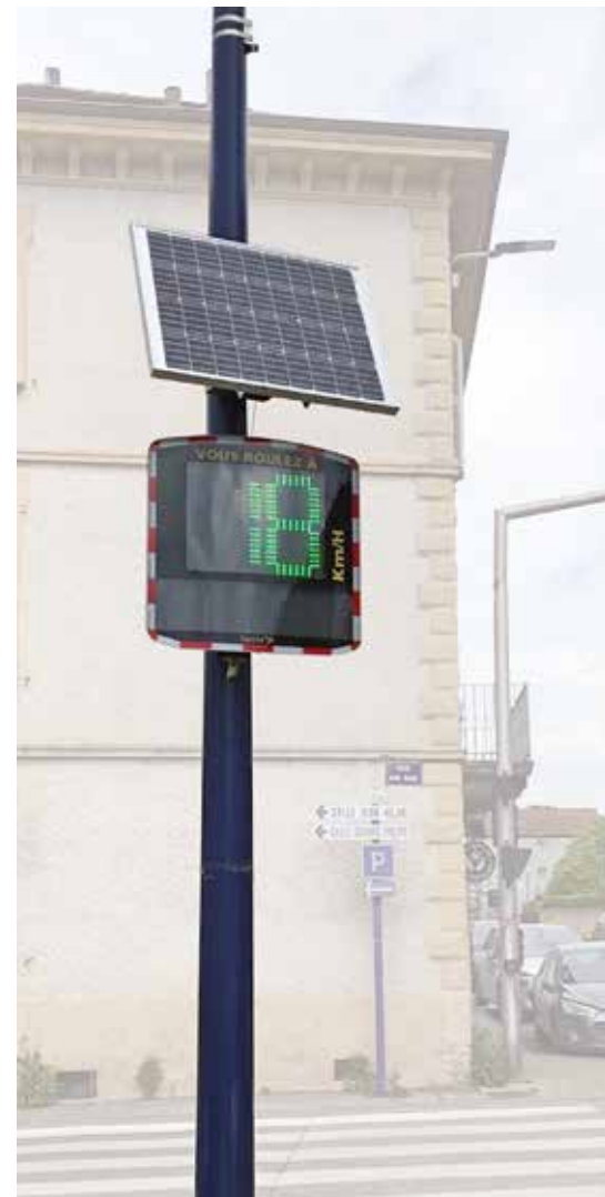
Radars situés boulevard de la Libération à proximité de l'école élémentaire
