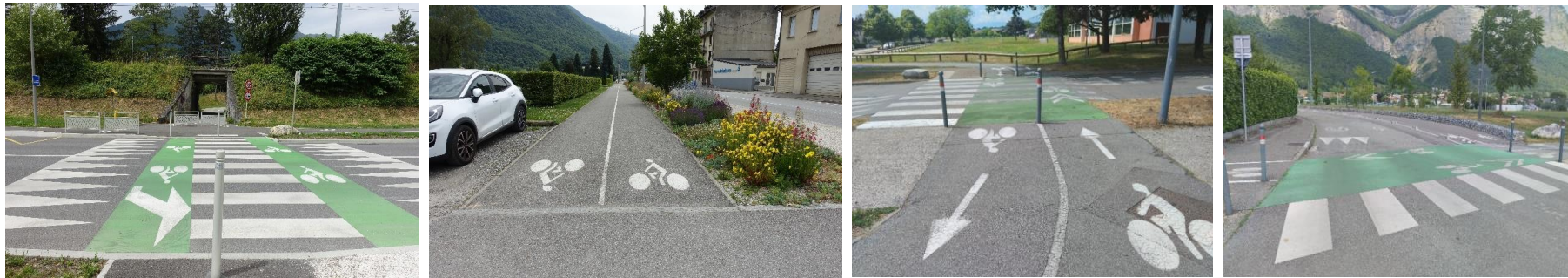
Aménagement cyclable Albertville (73), Crolles (38)
